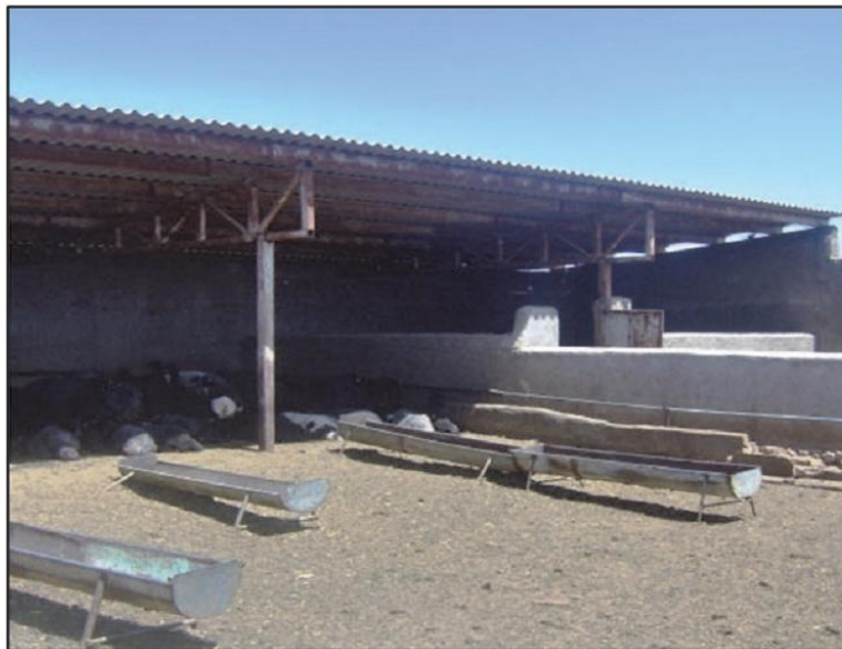
شکل ۵- جایگاه باز پرورش گوسفند فاقد دیوار جانبی در سمت مقابل
